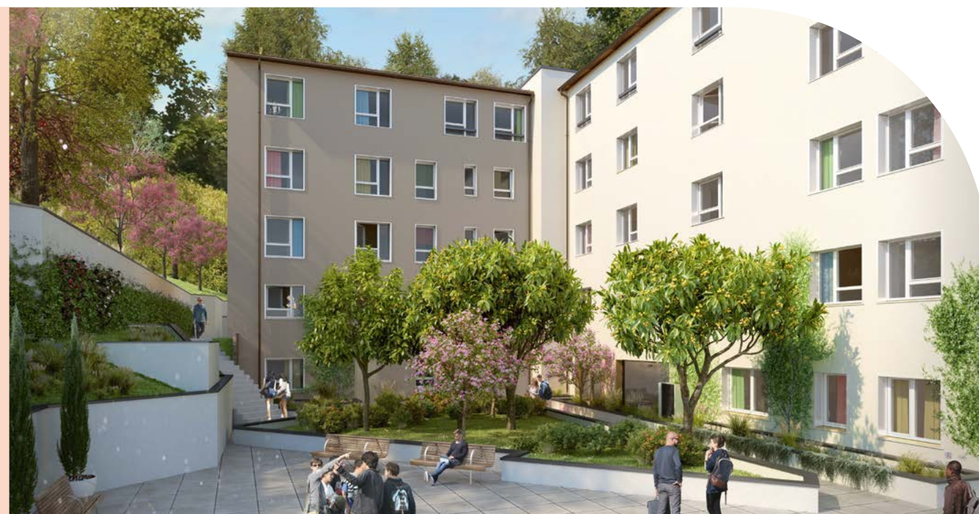
À ROUEN (76), UN ANCIEN ENSEMBLE DE BUREAUX EST RÉHABILITÉ ET TRANSFORMÉ EN UNE RÉSIDENCE ÉTUDIANTS STUDENT FACTORY.
